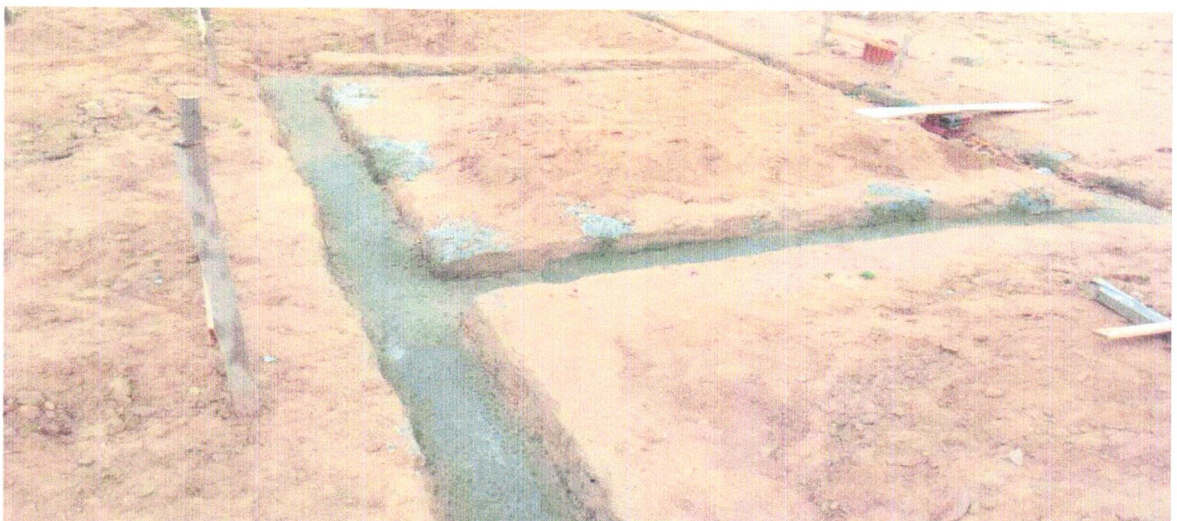
14 - LASTRO DE CONCRETO MAGRO, APLICADO EM BLOCOS DE COROAMENTO OU SAPATAS, ESPESSURA DE 3 CM.
