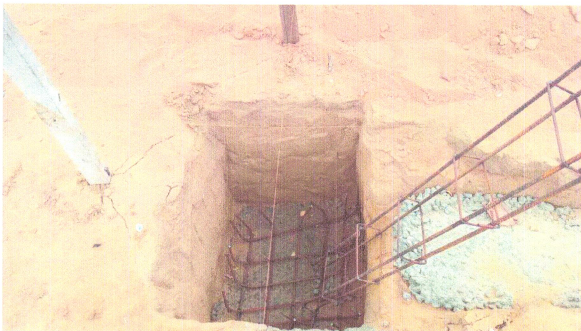
FOTO 03 - ESCAVAÇÃO MANUAL PARA BLOCO DE COROAMENTO OU SAPATA (INCLUINDO ESCAVAÇÃO PARA COLOCAÇÃO DE FÔRMAS). AF_06/2017
