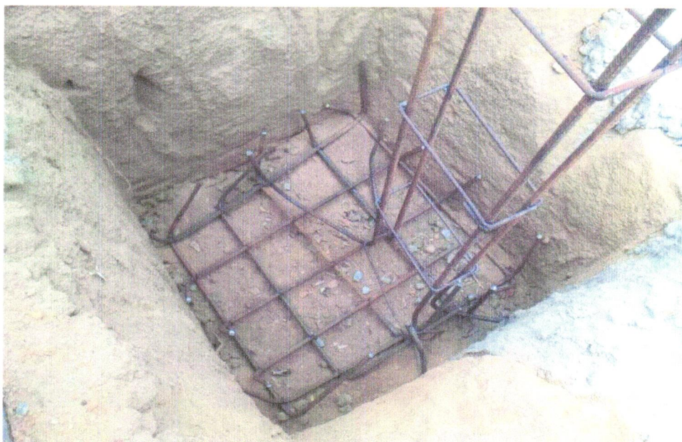
FOTO 02 – - ESCAVAÇÃO MANUAL PARA SAPATA AF_06/2017
