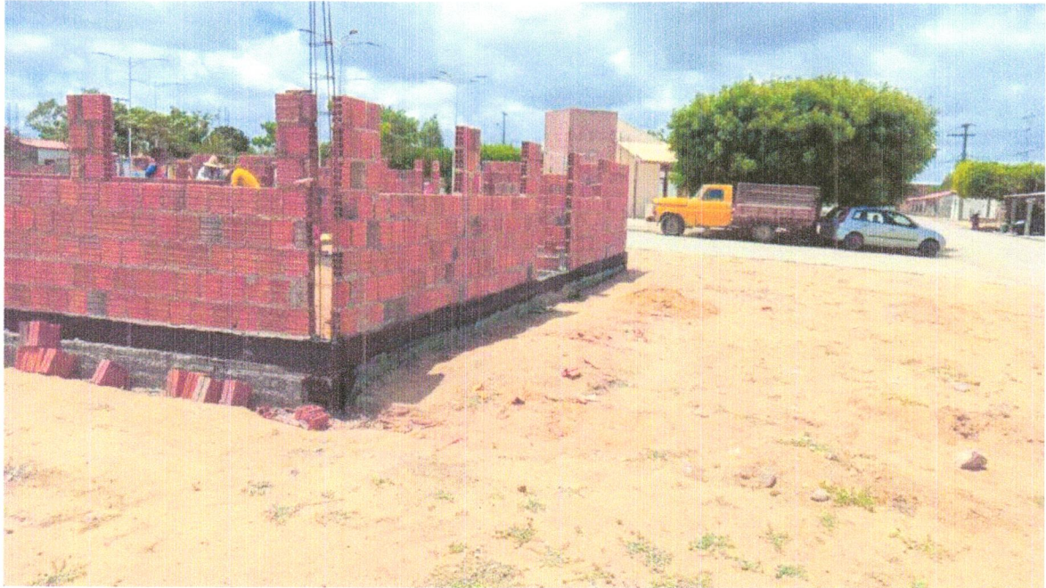
FOTO 7 – IMPERMEABILIZAÇÃO DE SUPERFÍCIE COM EMULSÃO ASFÁLTICA, 2 DEMÃOS AF_06/2018
