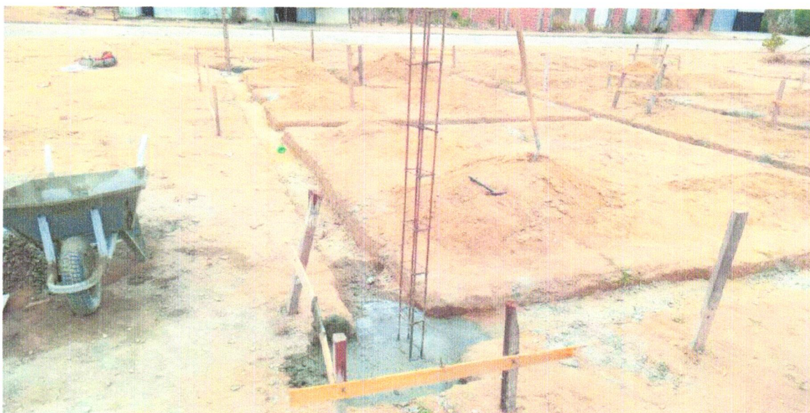
FOTO 05 – ESCAVAÇÃO MANUAL DE VALA PARA VIGA BALDRAME (INCLUINDO ESCAVAÇÃO PARA COLOCAÇÃO DE FÔRMAS). AF_06/2017
