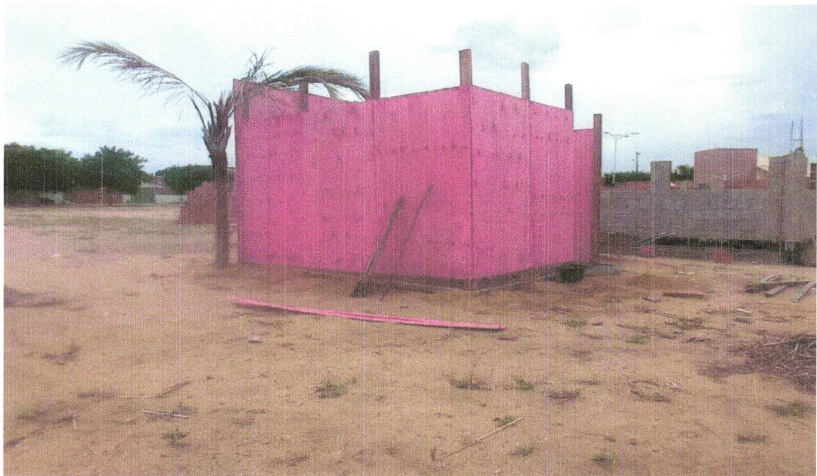
FOTO 10 - Barracão para Obras de Médio Porte Reaproveitamento
