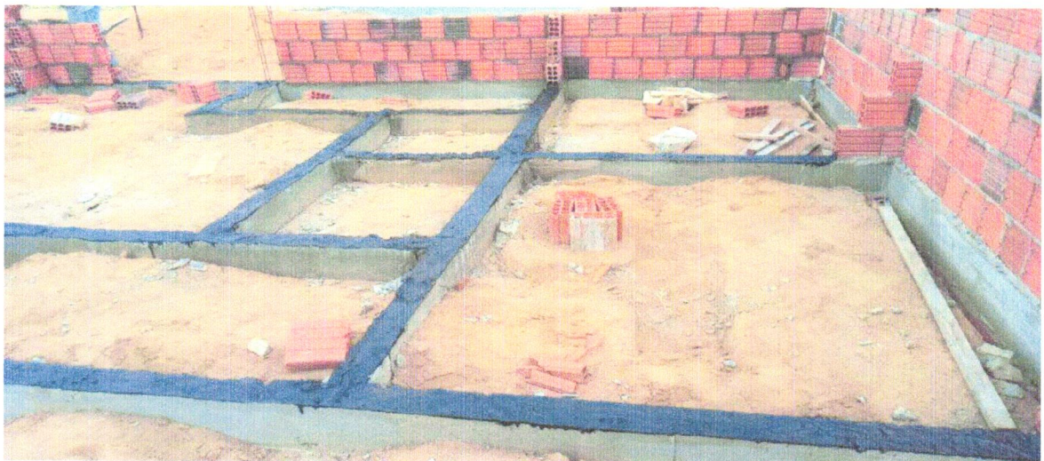
FOTO 12 - IMPERMEABILIZAÇÃO DE SUPERFÍCIE COM EMULSÃO ASFÁLTICA, 2 DEMÃOS AF_06/2018
