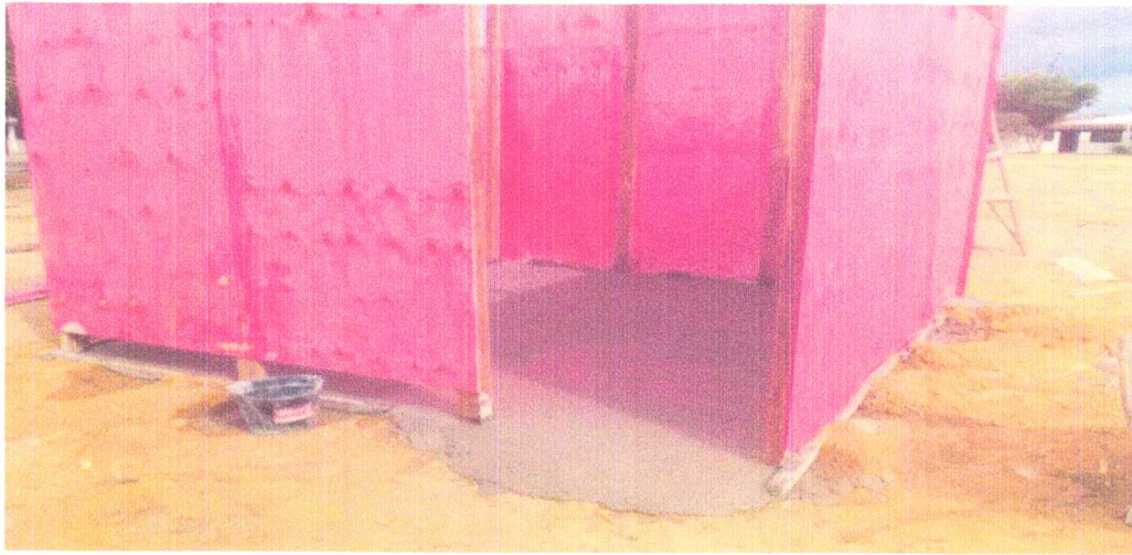
FOTO 09 – Barracão para Obras de Médio Porte Reaproveitamento
