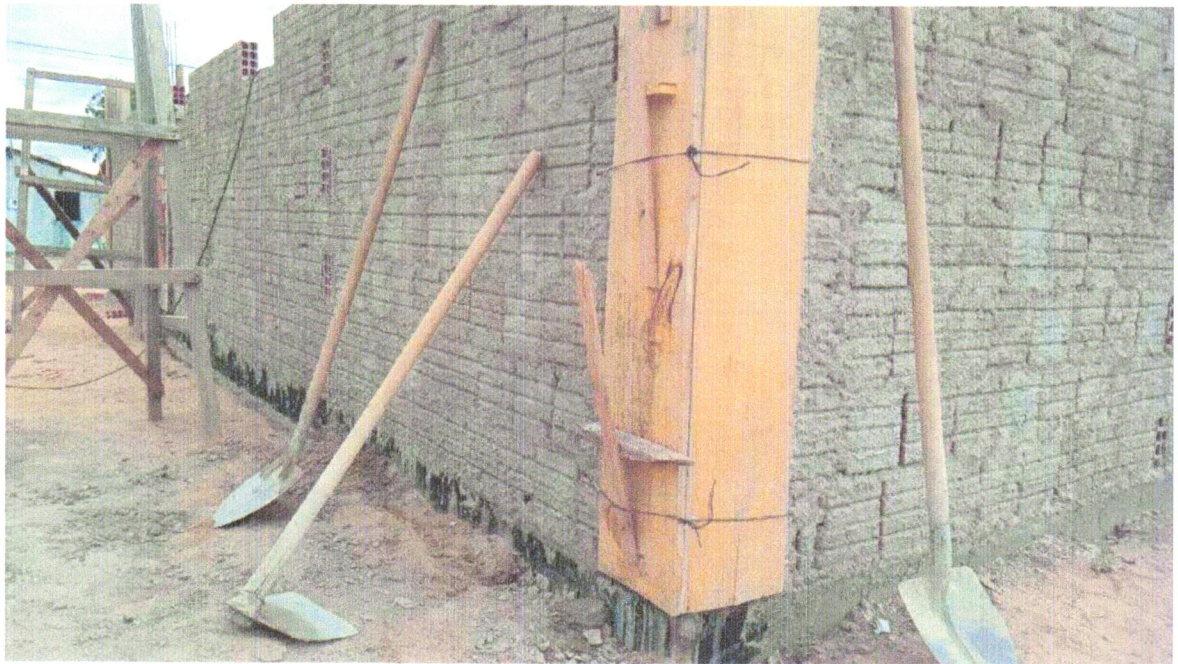
FOTO 13 – (COMPOSIÇÃO REPRESENTATIVA) EXECUÇÃO DE ESTRUTURAS DE CONCRETO ARMADO, PARA EDIFICAÇÃO HABITACIONAL UNIFAMILIAR TÉRREA (CASA EM EMPREENDIMENTOS), FCK = 25 MPA. AF_01/2017 E CHAPISCO APLICADO EM ALVENARIAS E ESTRUTURAS DE CONCRETO INTERNAS, COM COLHER DE PEDREIRO. ARGAMASSA TRAÇO 1:3 COM PREPARO EM BETONEIRA 400L. AF_06/2014
